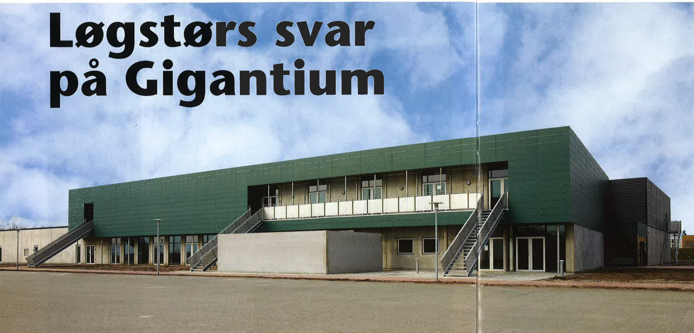
Mod syd/sydvest er glaspartierne udført med en fast solafskærmning i form af skyggevirkninger fra udhæng.
