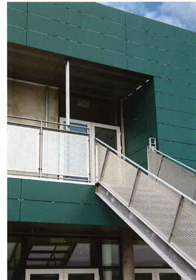
Mod syd/sydvest er glaspartierne udført med en fast solafskærmning i form af skyggevirkninger fra udhæng.
